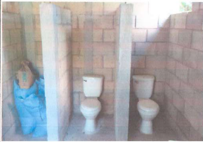
Foto 1: Mejoramiento de servicios sanitarios
