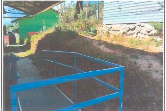
Foto 2: Mejoramiento de muro perimetral
