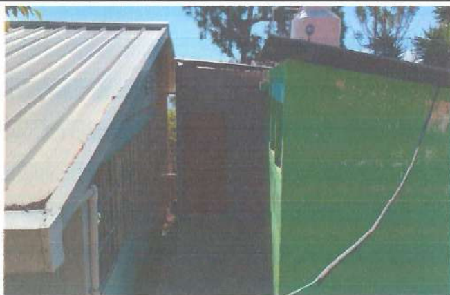
Foto 3: Mejora de estructura de techo de corredor
